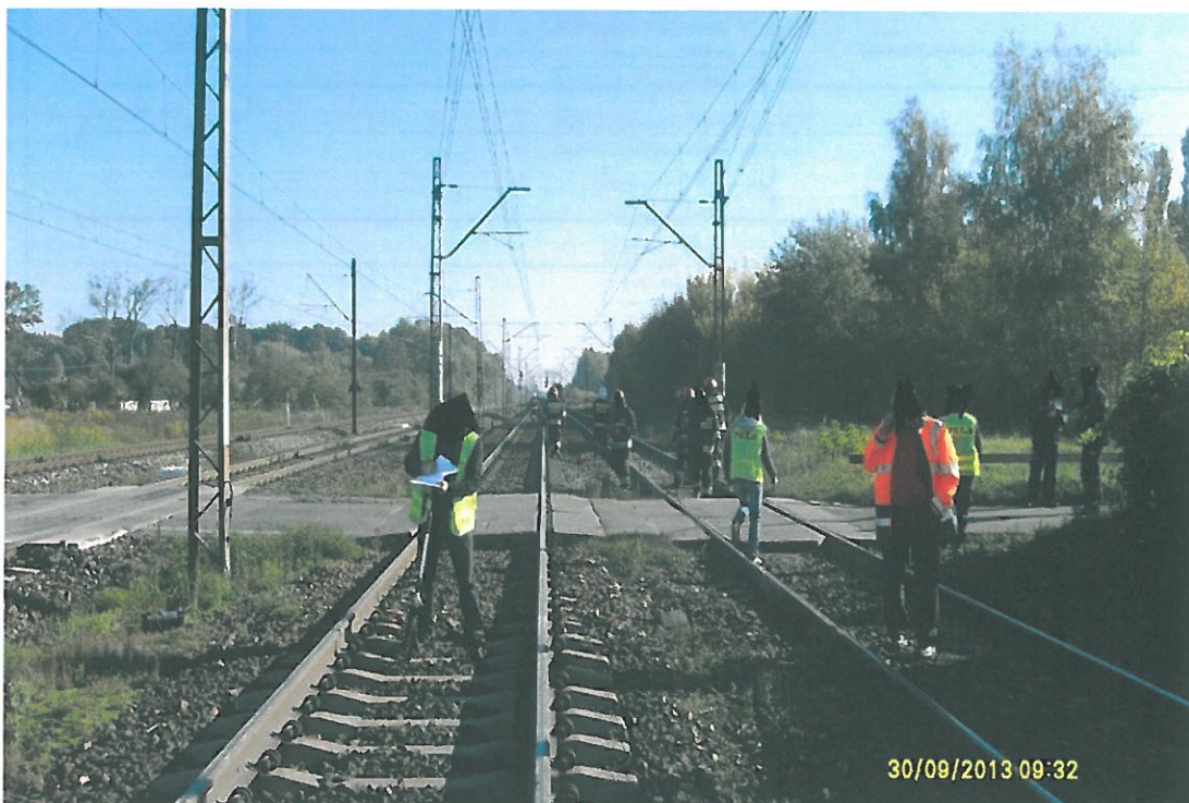
Widok nawierzchni przejazdu – widok z boku.
