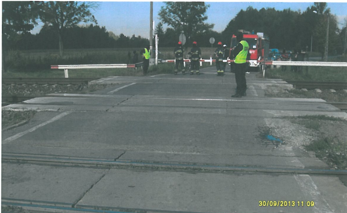
Widok nawierzchni przejazdu .
